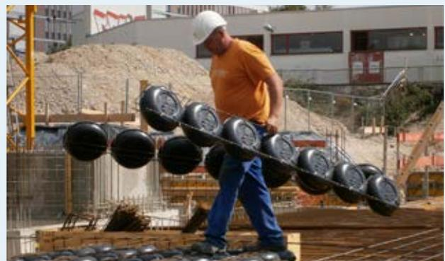
Bei dem Kooperationsprojekt entwickelte die Cobiax Technologies GmbH die Konstruktion der Hohlkörper und ihrer Komponenten sowie die Abstufung des modularen Systemaufbaus für eine optimale Belastbarkeit und Verarbeitungsfähigkeit. Weitere Aufgaben waren Entwicklung, Erprobung und Optimierung des Herstellungs- und Verarbeitungsverfahrens.
