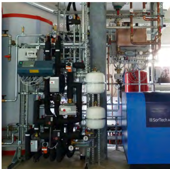
Anlage zur solaren Kühlung an der Richard-Fehrenbach-Gewerbeschule in Freiburg. Eingebaut wurde dort eine Adsorptionskälteanlage, die mit solarer Wärme betrieben wird.
