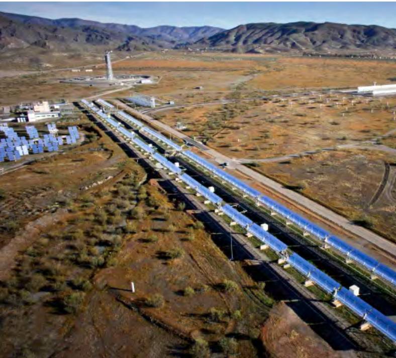
Neue DISS-Testanlage auf der Plataforma Solar de Almería in Spanien.
