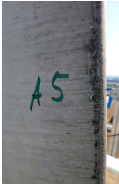
Inspektion einer durch Regen erodierten Rotorblattoberfläche
