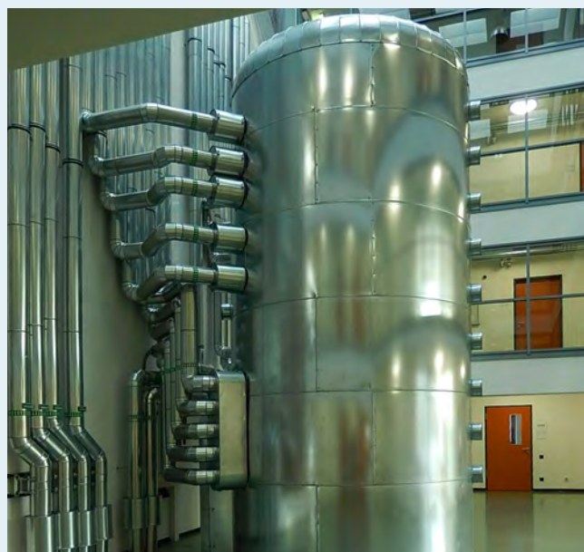
Wärmespeicher im Eingangsbereich des Energiezentrums der BTU Cottbus.
