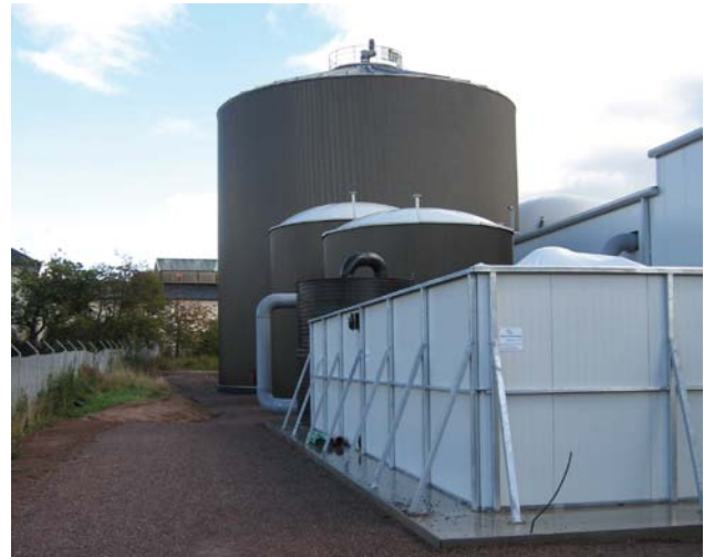
Fermenter mit Biofilter
