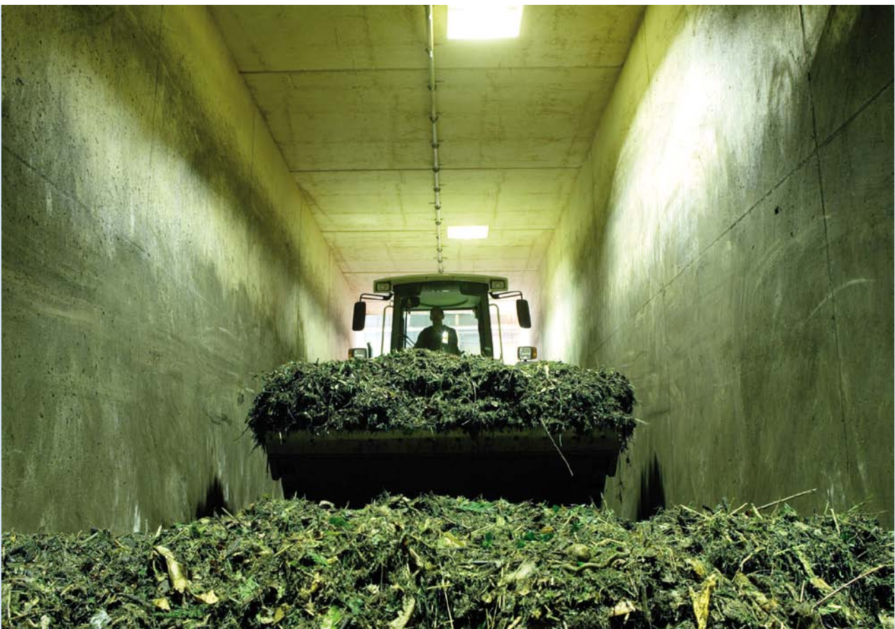
Rottetunnel eines Kompostwerks
