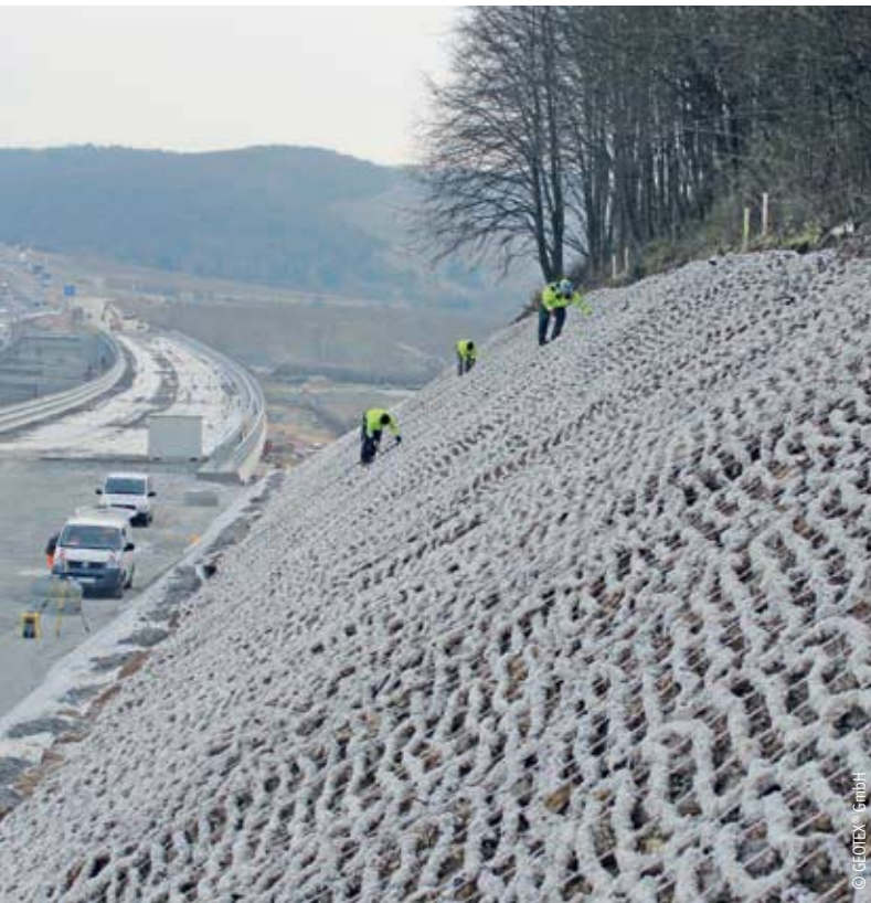
Schafwoll-Erosionsschutzmatten schmiegen sich dem Boden optimal an und verhindern selbst in Erosionsrinnen weiteren Abtrag.
