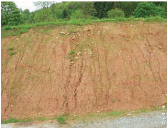
Erosionserscheinungen an einer Straßenböschung
