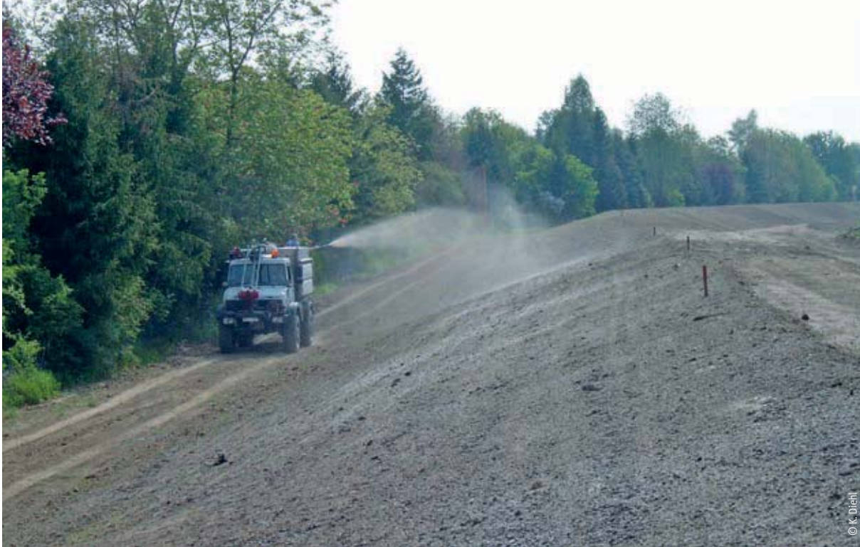
Anspritzbegrünung mittels Hydroseeder
