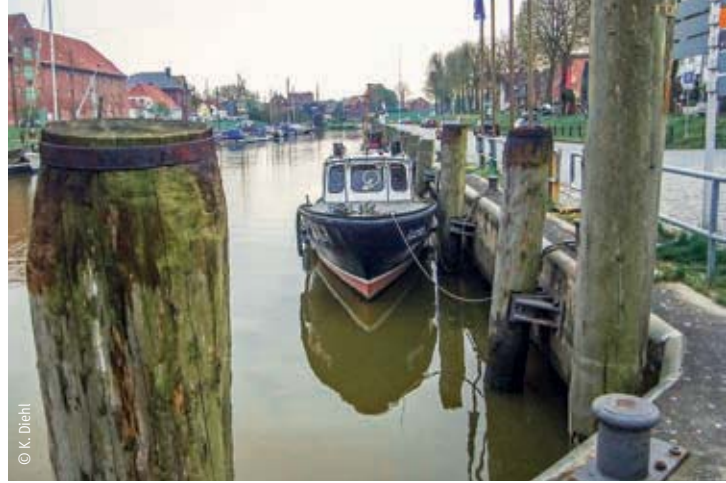
Holz-Dalben in einem Hafen: Gebrauchsklasse 5
