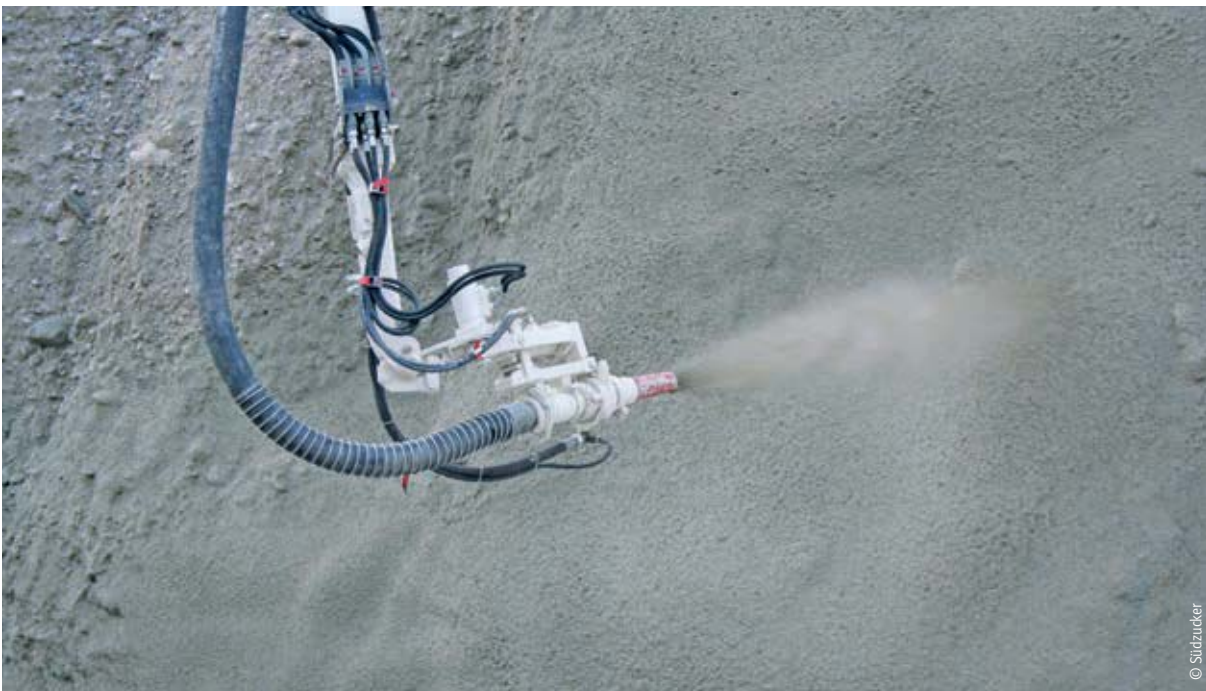
Die Beimischung von Stärkeether im Spritzbeton kann Materialverluste und Staubbildung mindern.
