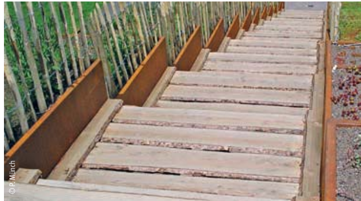
Holztreppe, der Witterung ausgesetzt: Gebrauchsklasse 3.2
