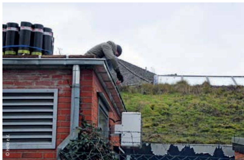
Aufbringen von Dachbitumenbahnen
