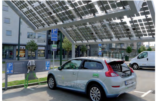
Abbildung 28: Solartankstelle © Jörg Thiemann-Linden
