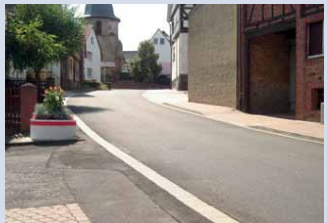
Ortsdurchfahrt K69 Borken-Nassenerfurth nach Fertigstellung
